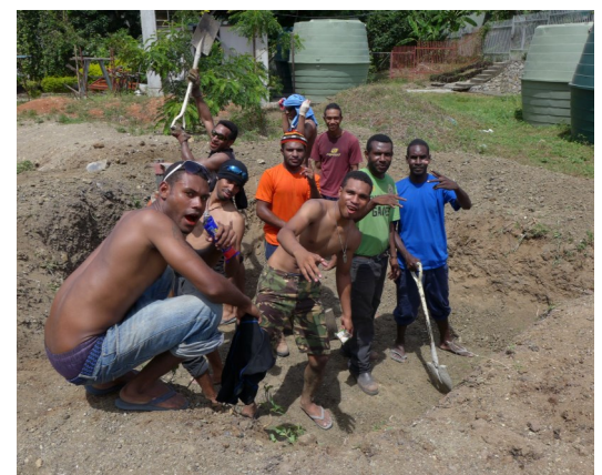
Die Studenten/innen graben eine Abfallgrube bei DBTI
